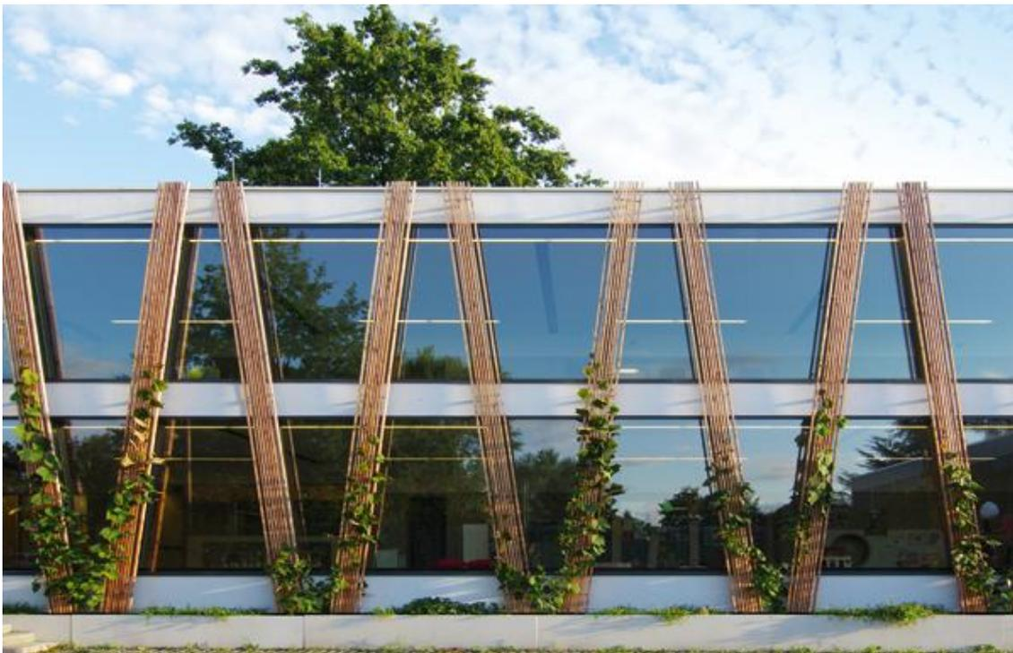
Imagen 6: Fachada con trepadoras sobre bastidor
